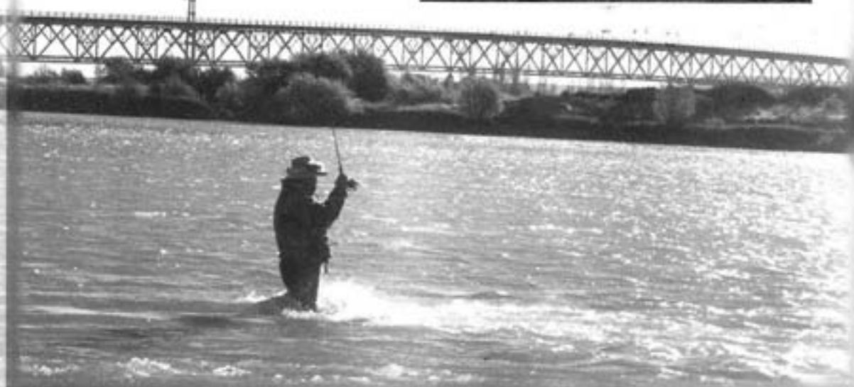
● Puente sobre la ruta tres
